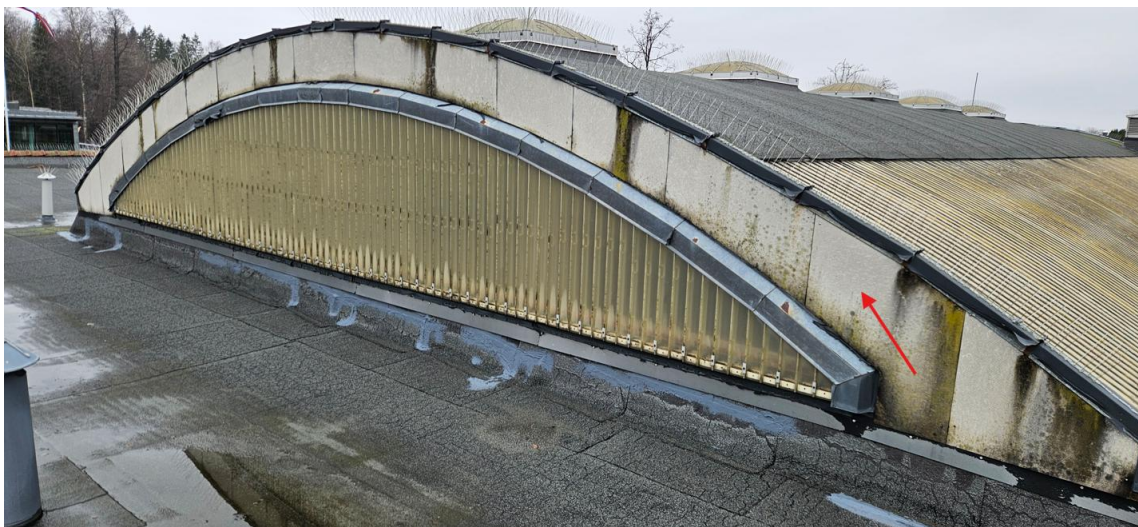
Figur 11 ▼ Eternittplater, kledning på gavl av buet takoppbygg. Asbestholdig
