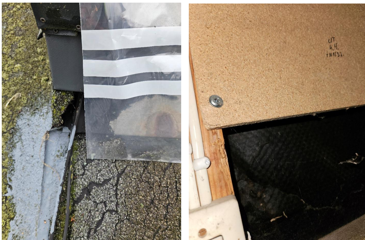
Figur 9 Takpapp og veggpapp - ikke påvist asbestinnhold
