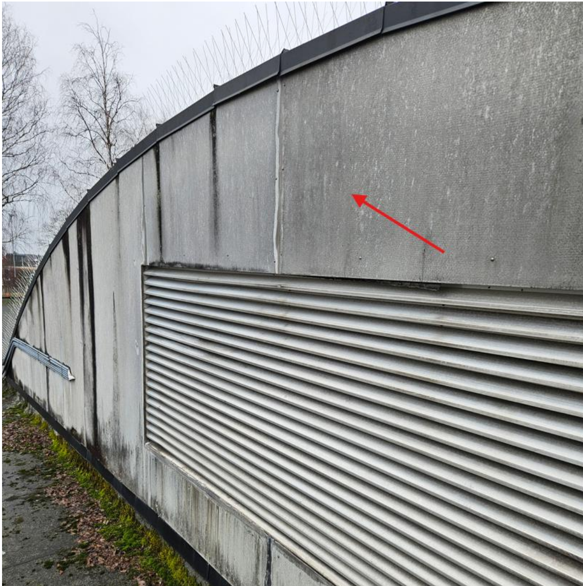
Figur 10 - ▼ Eternittplater, kledning på gavl av buet takoppbygg. Asbestholdig
